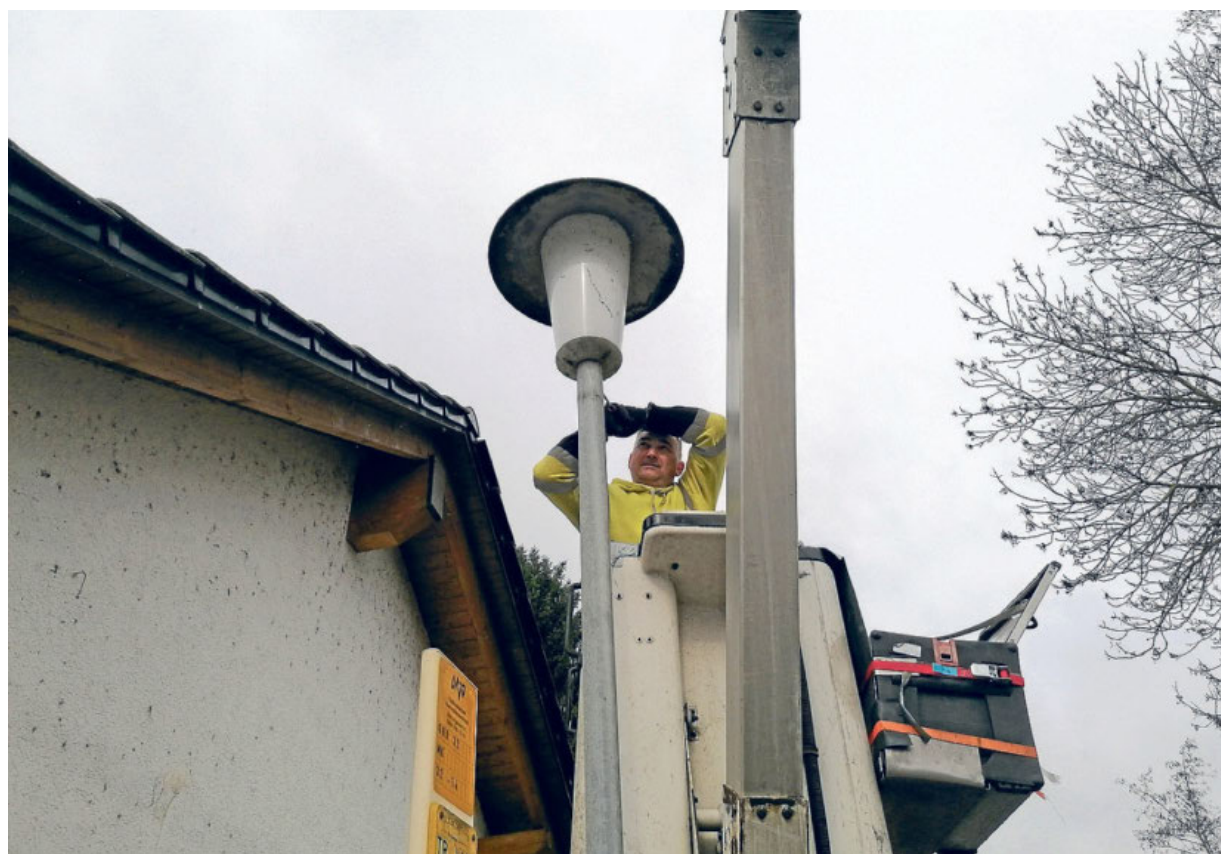
Austausch einer Lampe in Hoffenheim. Die Geräte sind per Bluetooth dimm- und kalibrierbar. Foto: Tim Kegel
